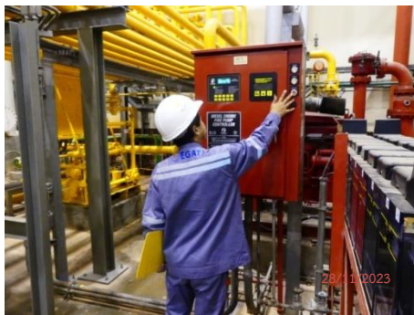
รูปที่ 2.2-27 การตรวจสอบ Fire Pump
